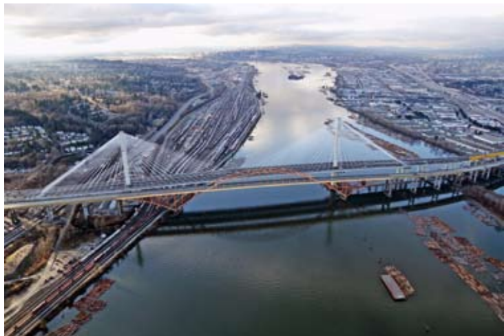
Port Mann Bridge, Kanada
