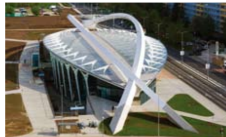
Stanice metra Strižkov, Praha, ČR, 2007
